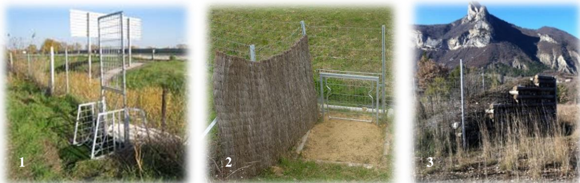
Exemples d'échappatoires : 1) trappe à sanglier Sanglipass, 2 : trappe basculante, 3 : rampe à cervidés Crédits photos : 1 et 3) Cabinet X-AEQUO-2) JF BRETAUD - CEREMA Ouest
